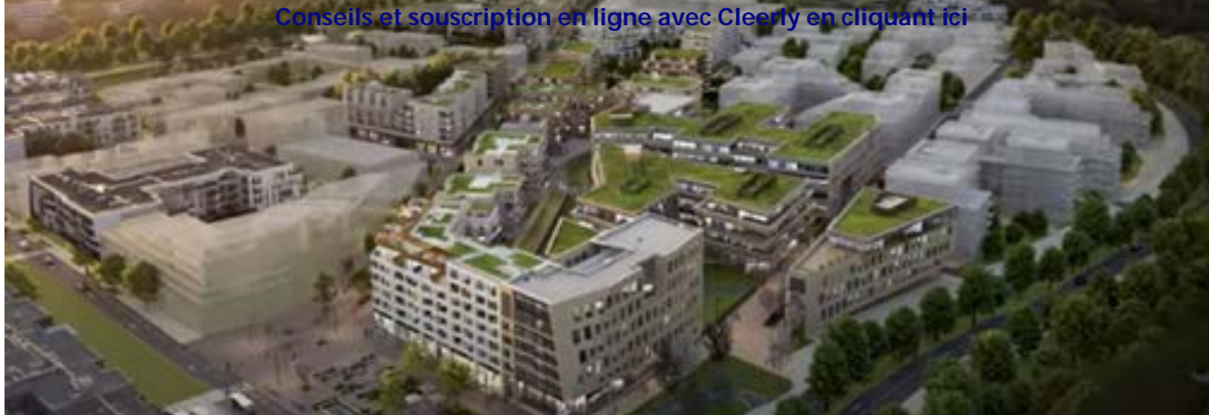
Rue Commerçante à Chatenay-Malabry
