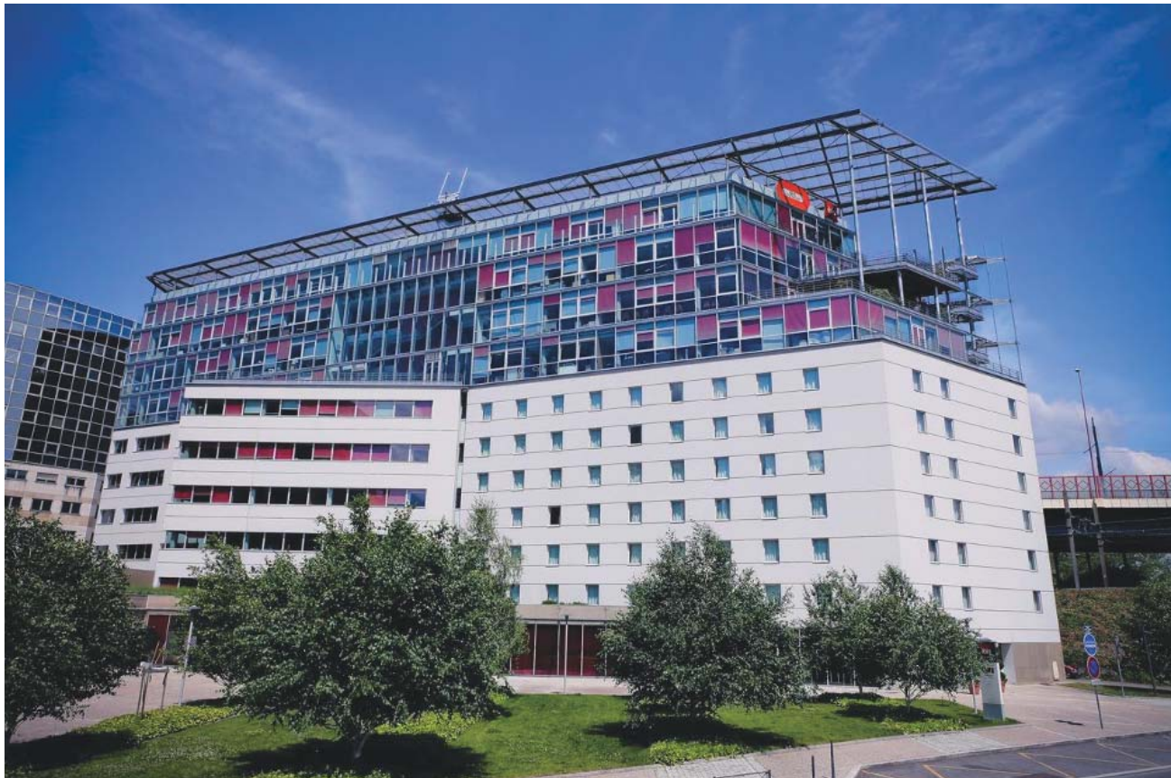
Immeuble « Saint Clair » - 5/7 avenue de Poumeyrol - Caluire et Cuire (69) Locataires : Cabot Financial France et Transdev
