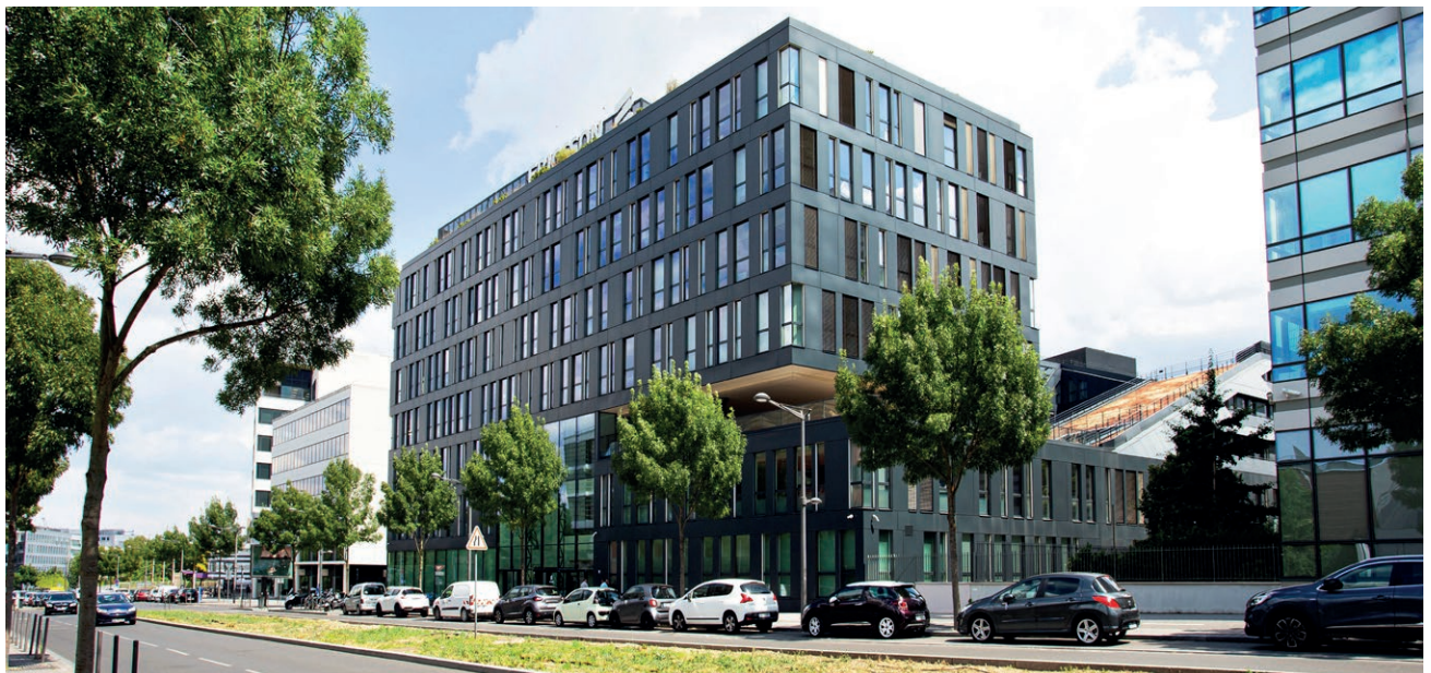
MASSY (91) - Immeuble Hélios
