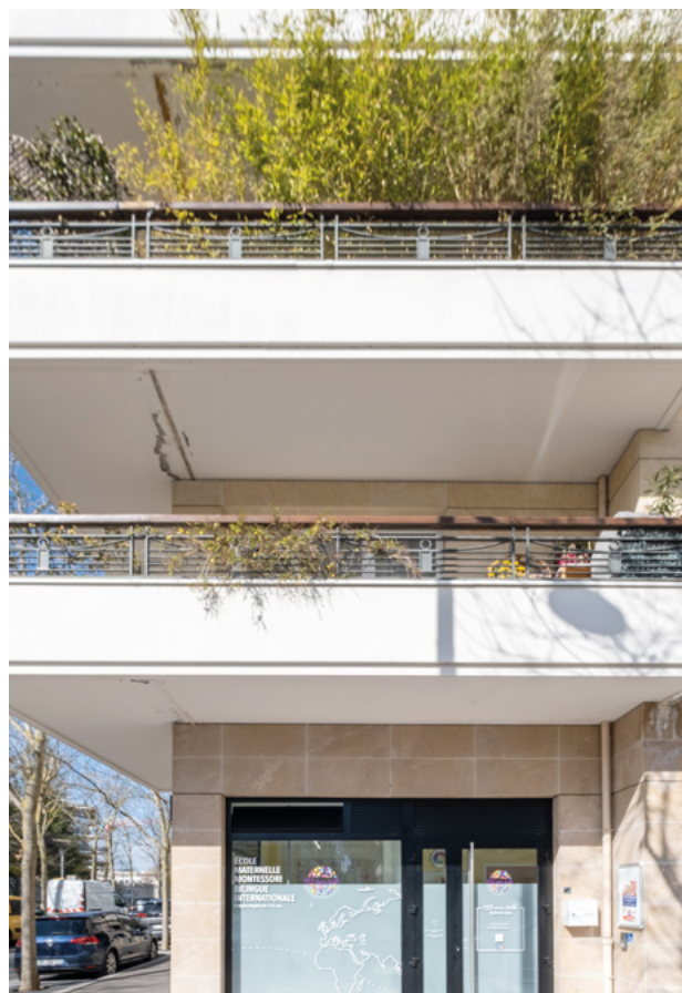
École maternelle en pied d'immeuble - 25-27 bis, rue du Capitaine Guynemer - Bois-Colombes (92)
