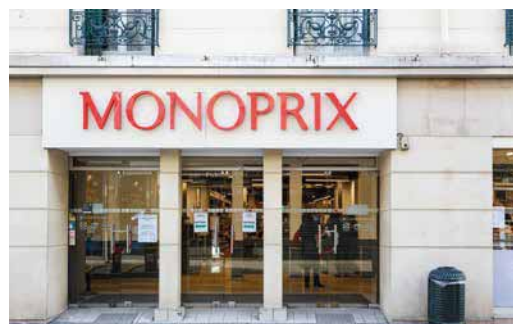
Crédit photo : Puteaux-Rue Jean Jaurès - myphotoagency
